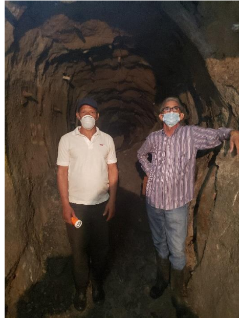
Anexo 4.- E0+230 m, Último tramo limpio.
