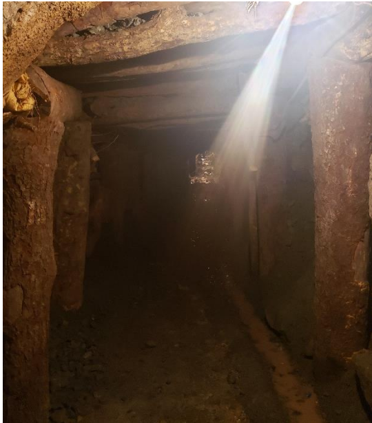
Anexo 3.- E0+210 m, Entibado de madera.
