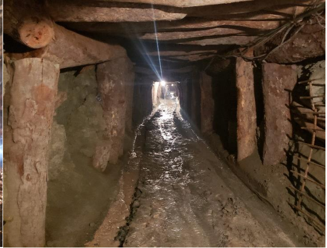
Anexo 2.- E0+135 m, Entibado reparado.
